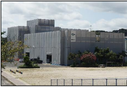
【足場に幕がかかった校舎】
