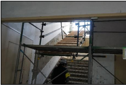
【改修中の校舎内】
